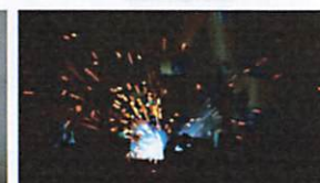
建設機械の溶接
