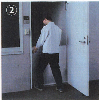
② ラクセット SD タイプをドア枠にはめ込み、 上から押しつけます。
